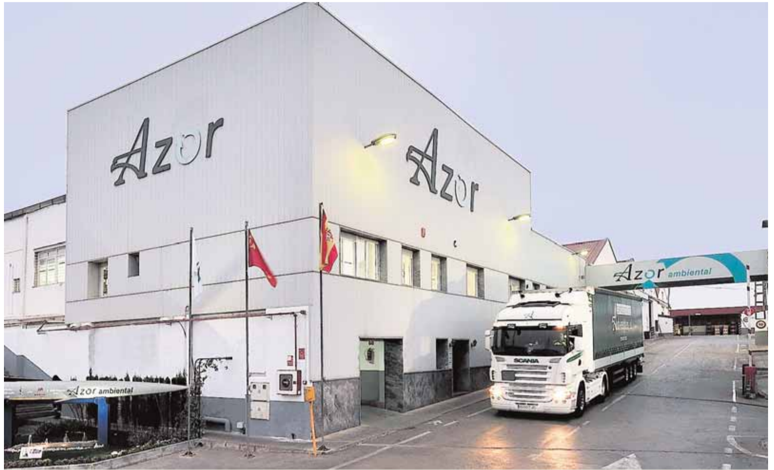
Puerta de entrada a las instalaciones de Azor Ambiental, situado en el polígono industrial 'La Polvorista', en Molina de Segura. A. A.
